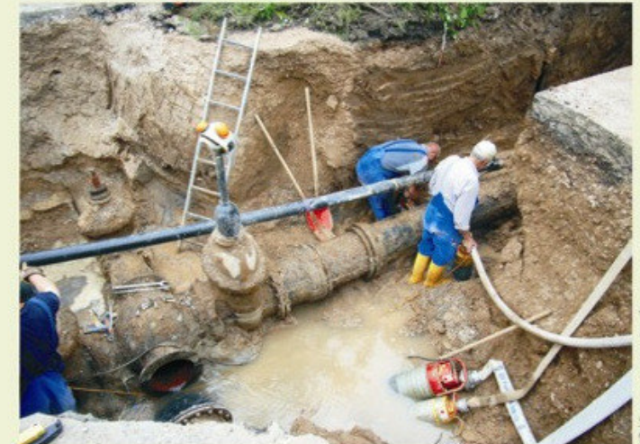
Wartung der Wasserleitung; Foto H. Heck
