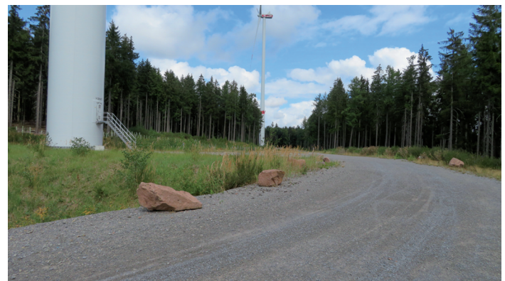
Bild 4: Wegebau und Geländemodellierung für Windkraftwerke auf dem Gipfel des ursprünglich dicht bewaldeten Stillfüßel bei Waldmichelbach
