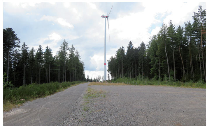
Bild 5: Dauerhaft gerodeter Wald für die Arbeitsfläche eines Windkraftwerkes auf dem Stillfüßel
